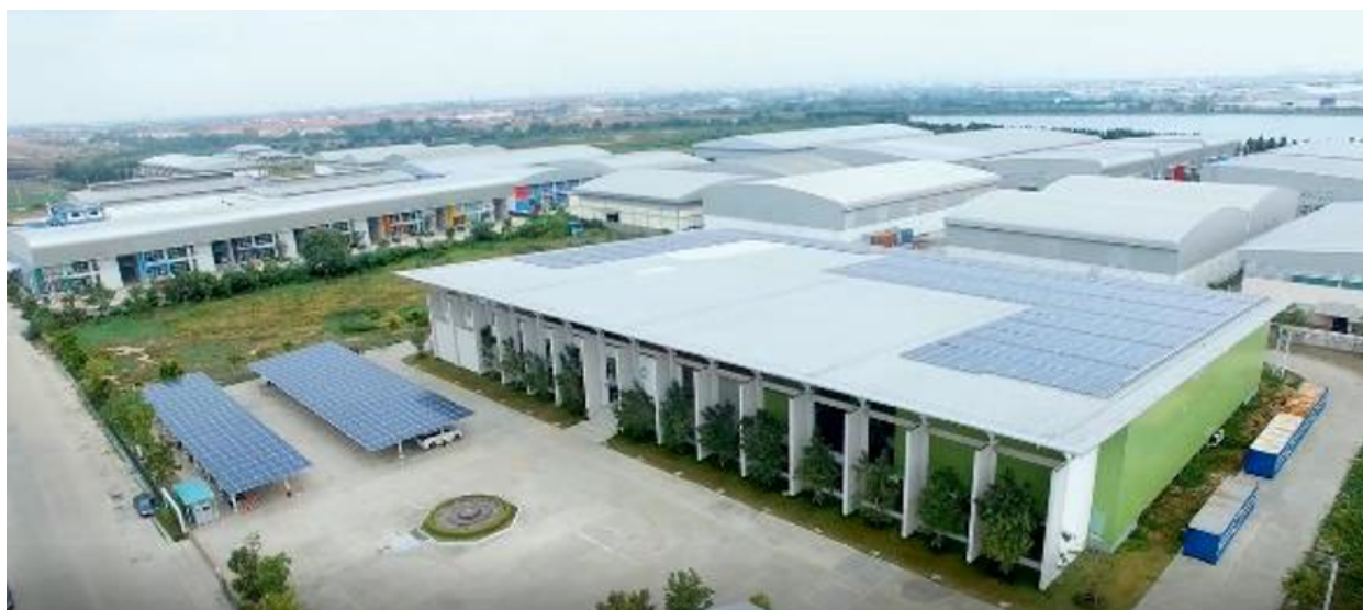
ภาพระบบผลิตไฟฟ้าจากพลังงานแสงอาทิตย์ (Solar Cell) บริเวณโรงจอดรถและหลังคาอาคาร
